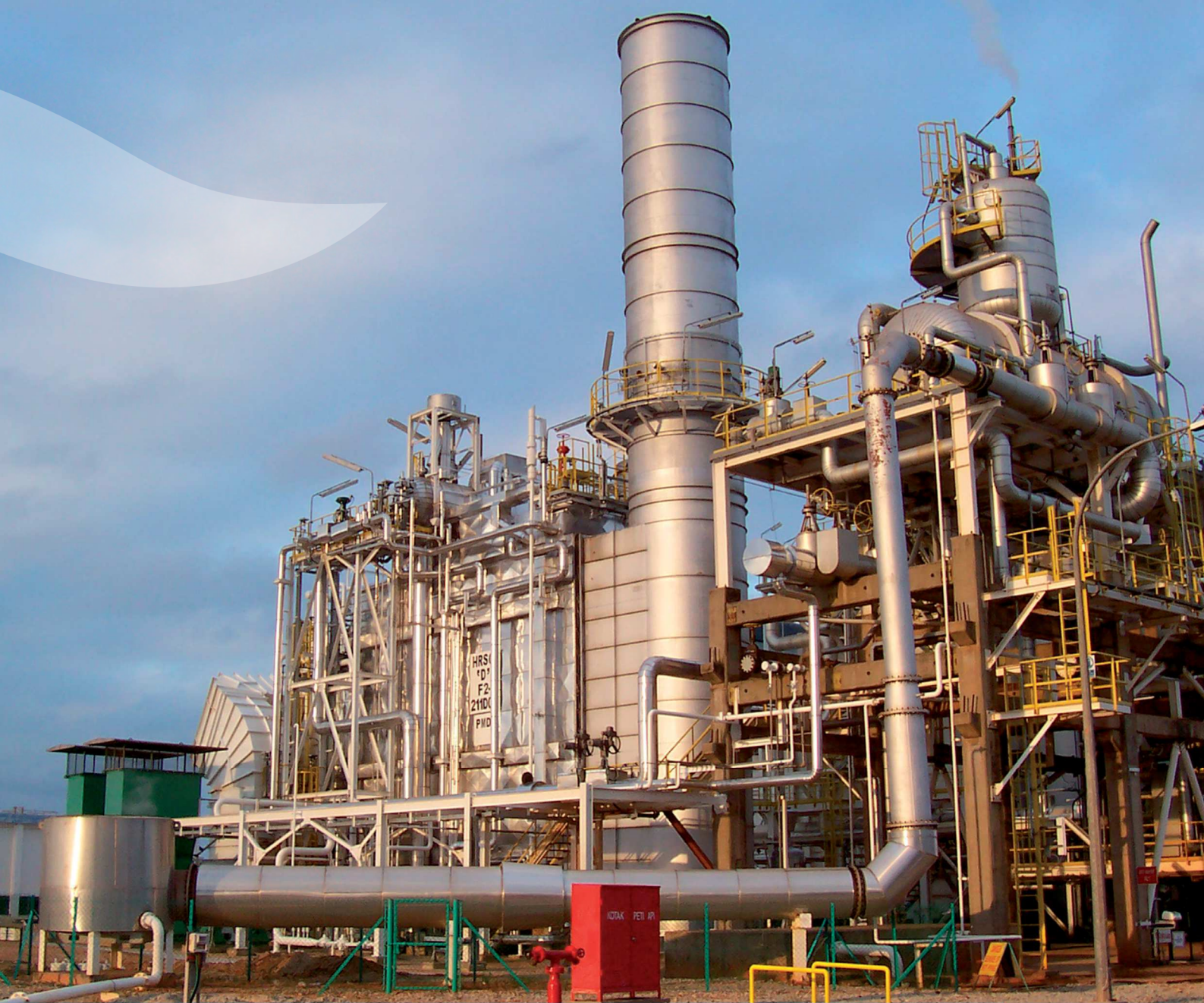
No. 1 HRSG behind 40 MW GT Malaysia
